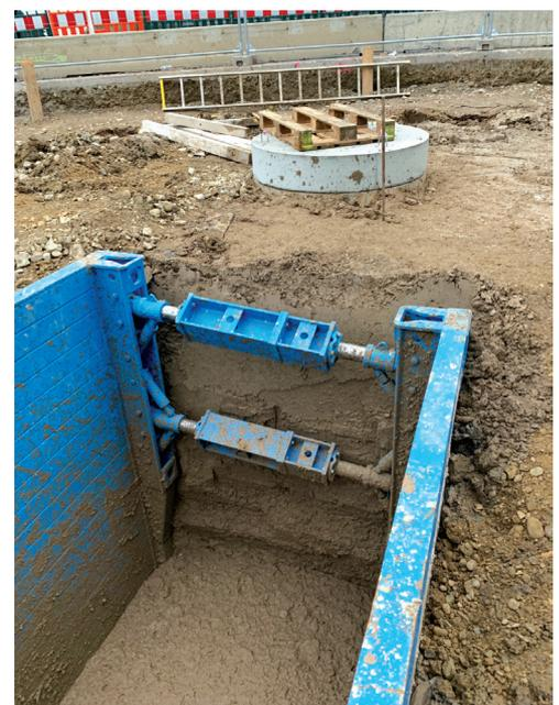
*Einbettung eines Kontrollschachtes in RSS-Flüssigboden auf der Baustelle am Europaplatz in Tübingen – links während des Verfüllvorgangs und rechts nach dem Ziehen des Verbaus.
