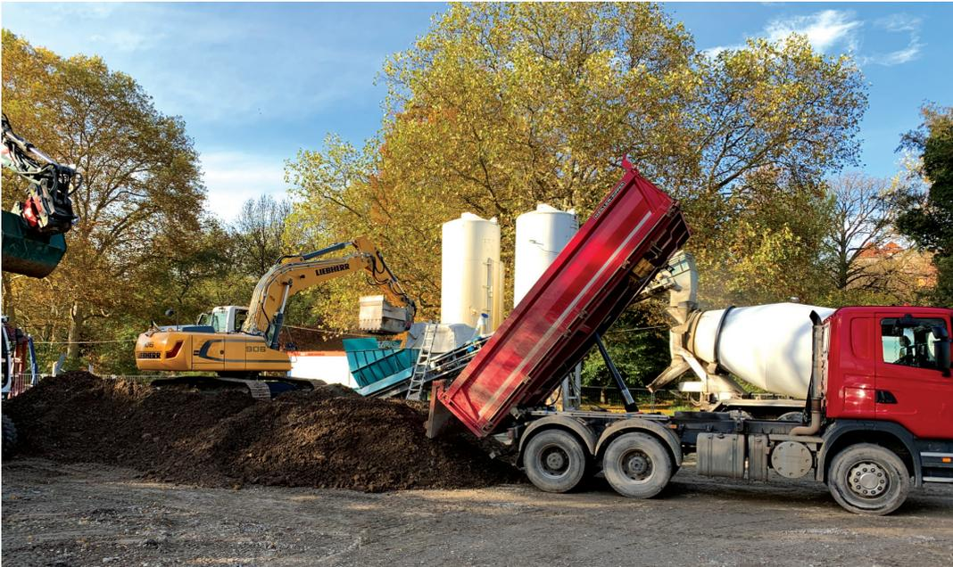
*So schaut eine 100% Erfüllung der Forderungen nach dem Kreislaufwirtschaftsgesetz aus: Der Bauaushub wird auf dem Mischplatz in Tübingen in einer Kompaktanlage zu RSS-Flüssigboden, mit Hilfe dessen dann sofort das ausgebagerte Grabensystem verfüllt wird.
