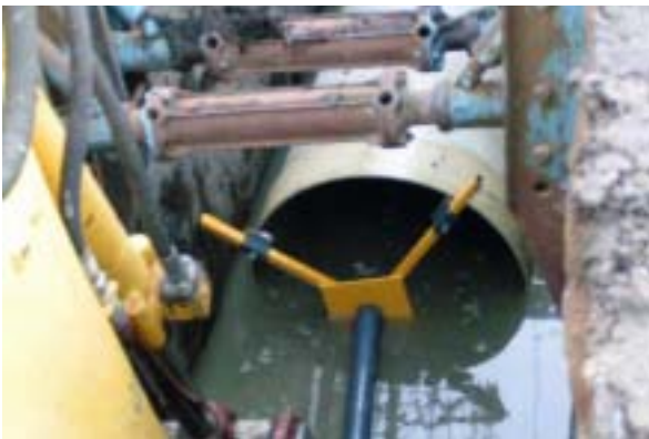
Schwimmende Verlegung in Lübeck im Wasser mittels RSS Rohreinschubhilfe und RSS Rohrverlegehilfe.
