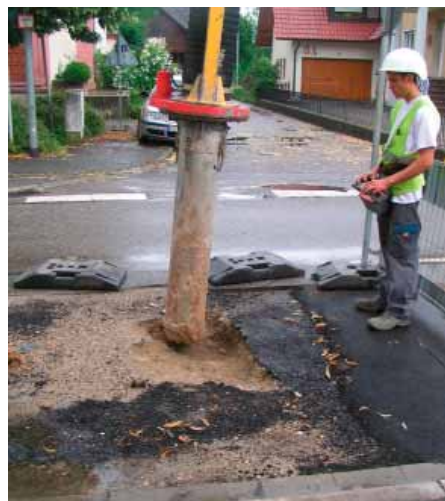
Aushub mit dem Saugbagger kann teure Handschachtung wirtschaftlich ersetzen.
