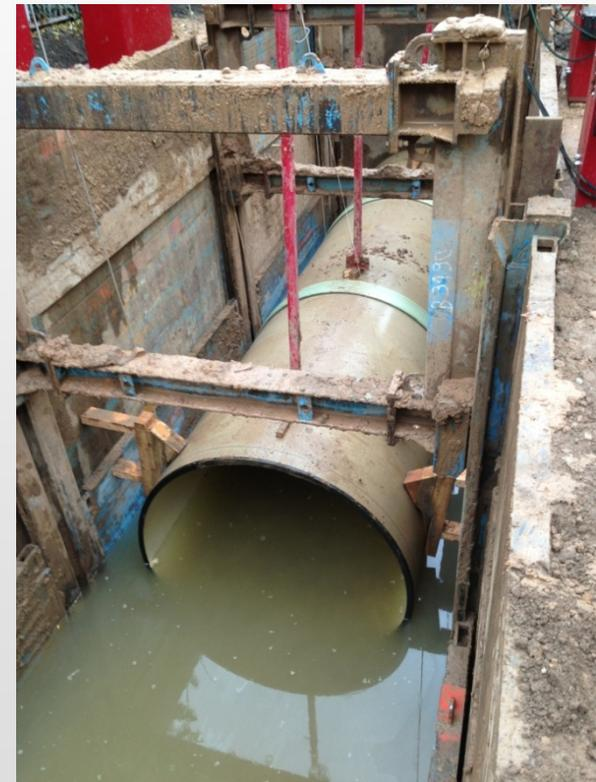
Строительство канализационных коллекторов также под уровнем грунтовых вод с помощью жидкого грунта RSS®
