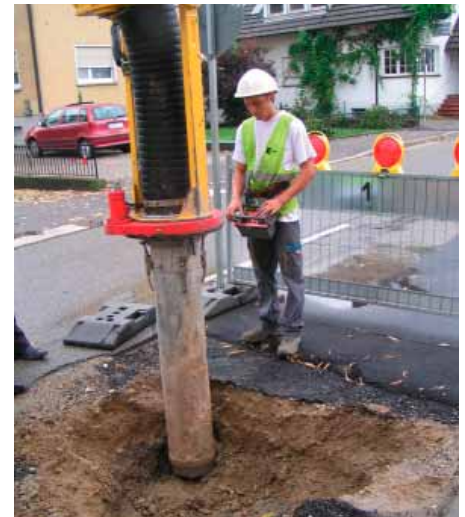
Saugbagger im Einsatz.
