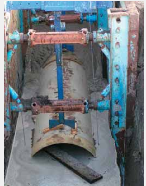
Flüssigboden verdrängt Wasser
