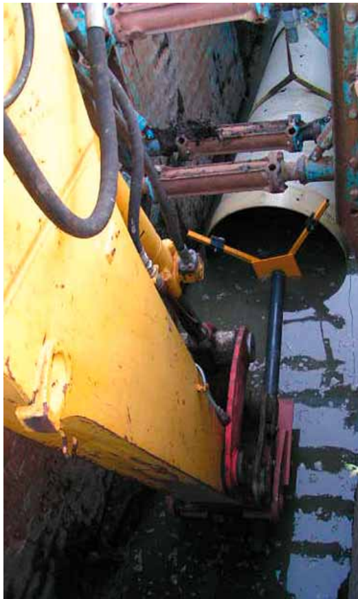
Fügen von Flowtite GFK-Rohren (Hersteller: Amitech) im Grundwasser mittels RSS Systemtechnik.
