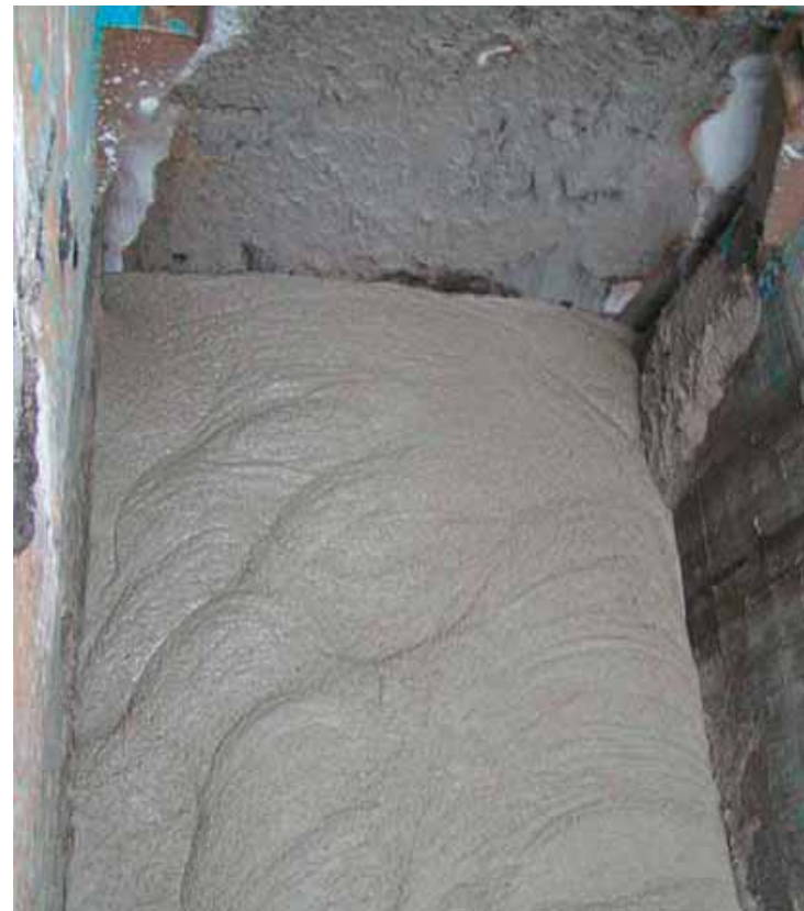
Verdrängung des Wassers durch RSS Flüssigboden und setzen des Querschotts
